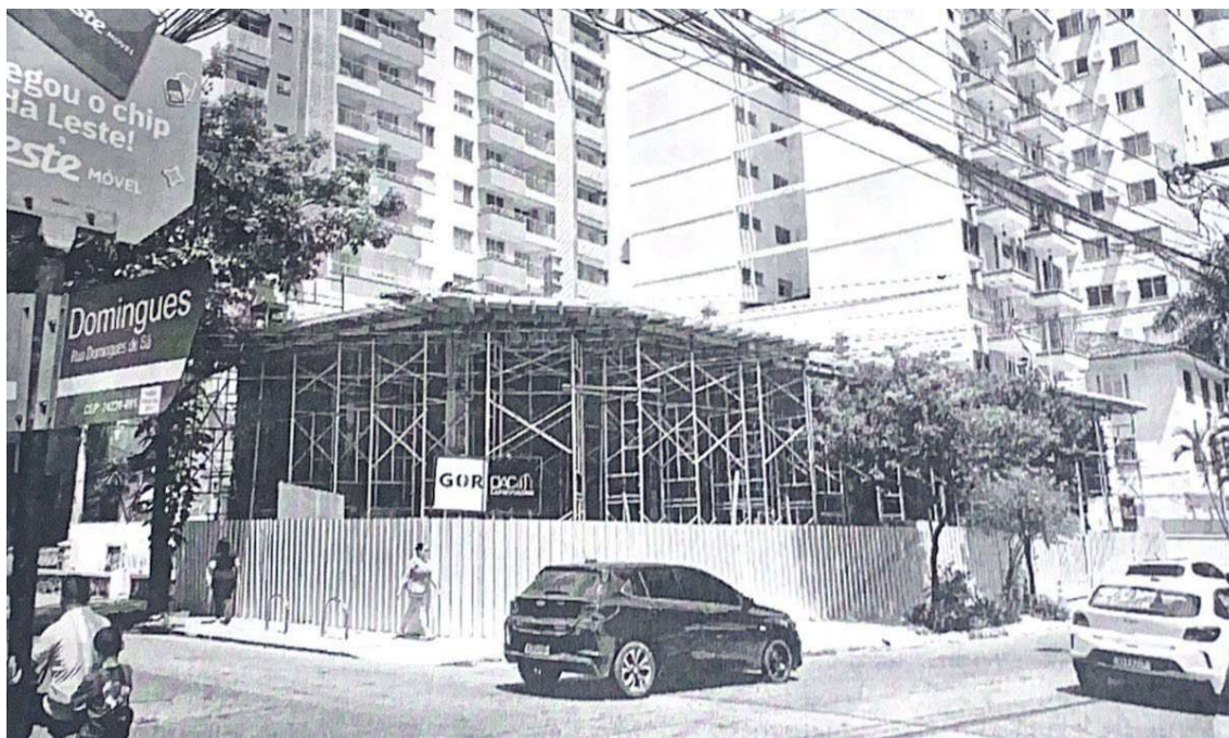
Figura 2. Registro fotográfico de fevereiro de 2025 feito por ocasião da vistoria procedida no imóvel.
